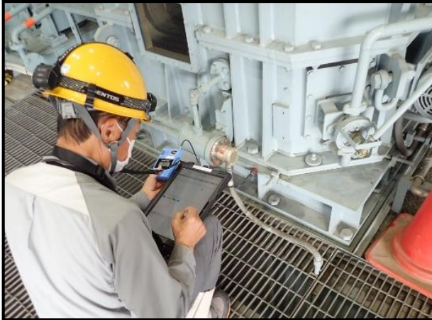
タブレットを利用した点検記録
