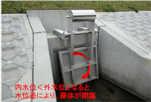
外水位側の水圧により、扉体が閉塞
