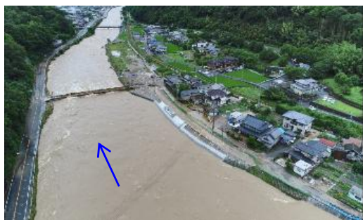
平成 30 年 7 月豪雨（府中市父石町付近）
