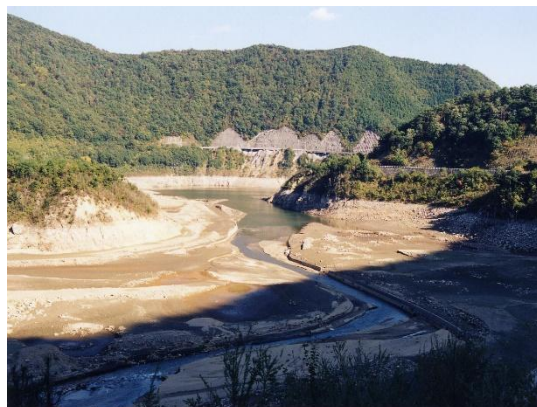
平成 14 年渇水（八田原ダム）
