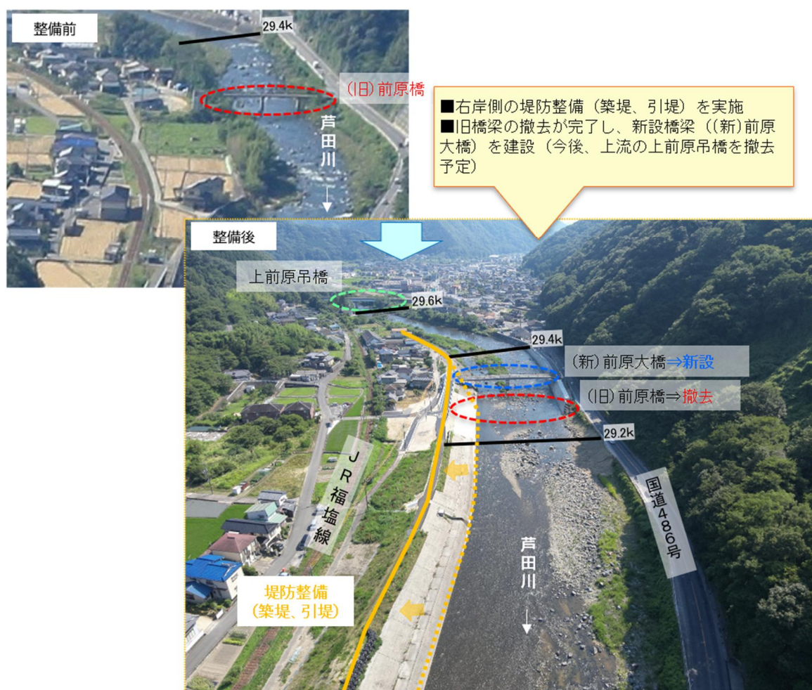
図 4-16 父石地区の堤防整備
