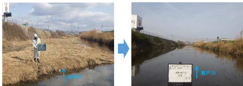
瀬戸川の河道掘削の実施状況（左：施工前、右：施工後）
