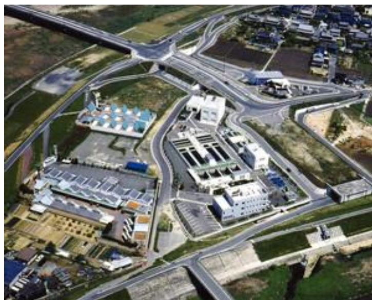
図 6-4 高屋川河川浄化施設
