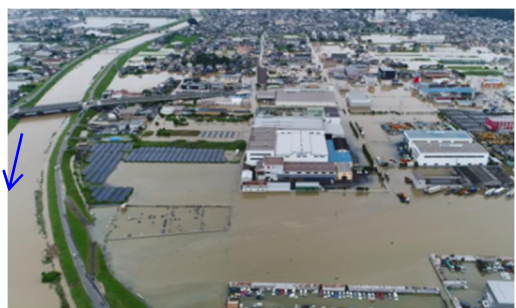
平成 30 年 7 月豪雨（福山市神辺町川南付近）
