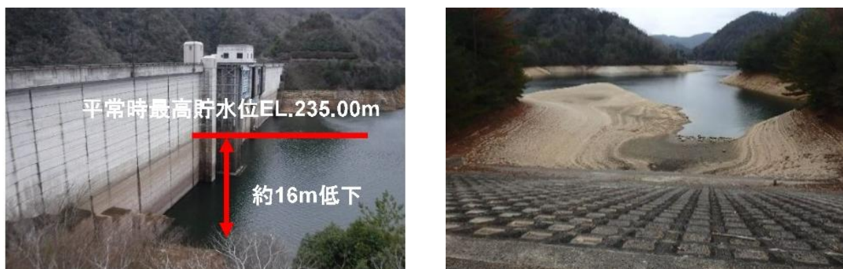
図 5-3 ダムの渇水状況（令和 5 年 12 月）（左：八田原ダム、右：三川ダム）
