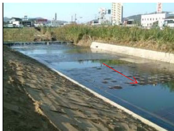
図 6-7 瀬戸川河川浄化施設の運用
