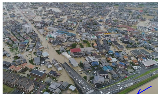
平成 30 年 7 月豪雨（福山市山手町付近）
