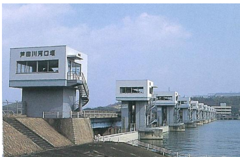
芦田川河口堰（昭和56年6月完成）
