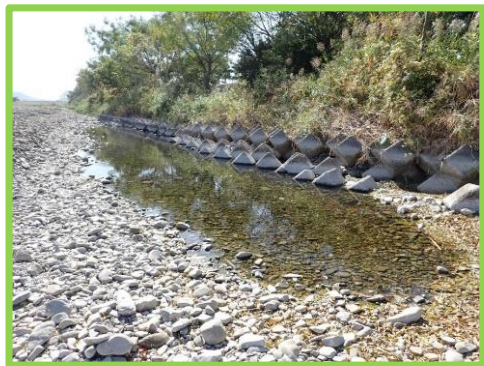
渇水時の下流孤立淵状況 (R5. 11. 8)
