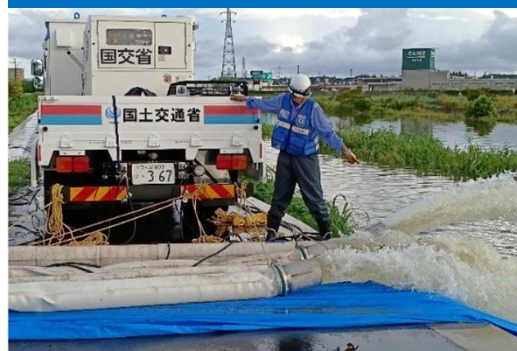
■排水ポンプ車による排水作業
