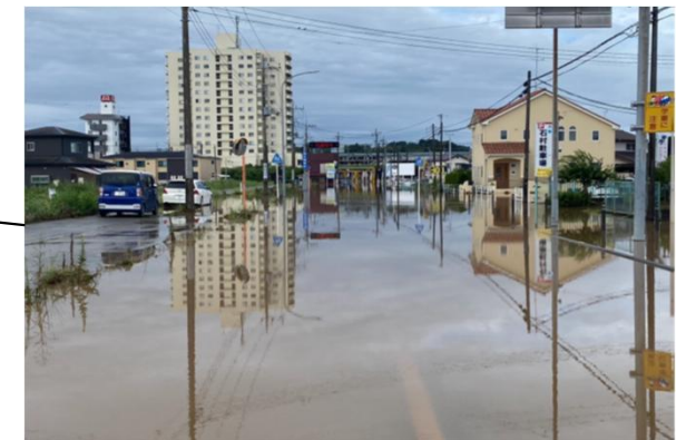
大網白里市 床上浸水168棟、床下浸水230棟
