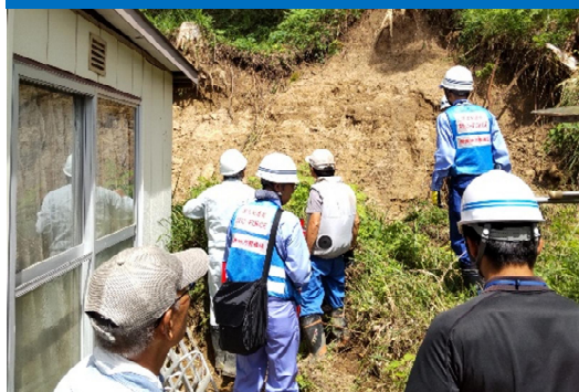
■土砂災害の被災状況調査
