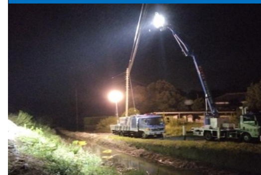
■照明車を活用した夜間作業
