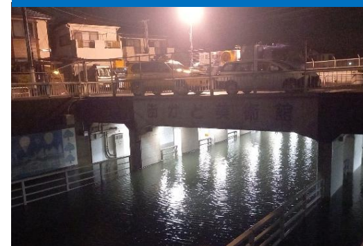
■アンダーパス部の排水
