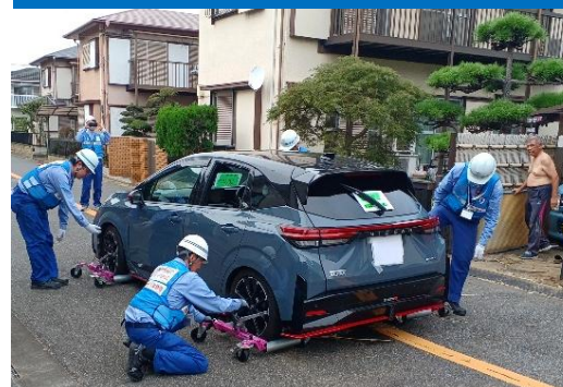
■被災車両の移動による道路啓開
