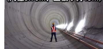
名古屋中央雨水調整池 (内径5.75m、土被り約45m)
