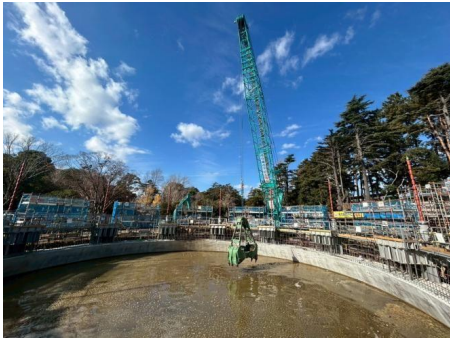
千葉市 弁天地区雨水貯留施設
