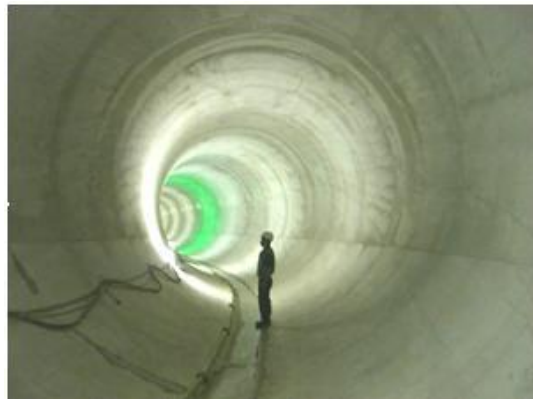
中央雨水1号貯留幹線 直径:5.25m 延長:5.1km
