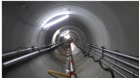
船橋市 山手1丁目地区雨水幹線
