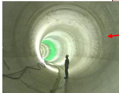
中央雨水1号貯留幹線 内径: 5,250mm 延長: 約 5.1km
