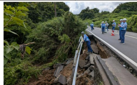
(主)生実本納線 (旧外房有料道路)(市原市)
