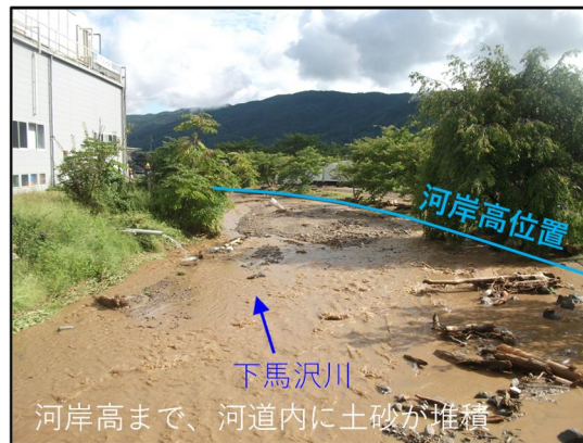
図.技 2-1-7-2 下馬沢川（天竜川水系、長野県）河口部における洪水後の土砂堆積状況
