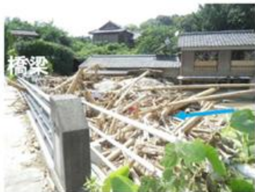
図.技 2-1-4-1 大量の流木堆積が生じた事例
