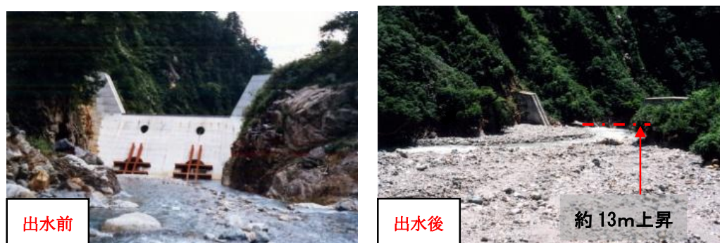
図 2.2 砂防事業の効果（平成 7 年（1995 年）7 月出水）（祖母谷第 6 号砂防堰堤）
