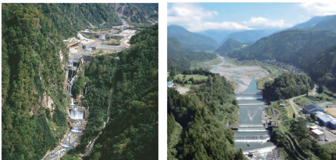
図 2.2 流域内の砂防堰堤（左図：白岩砂防堰堤 右図：本宮砂防堰堤）
