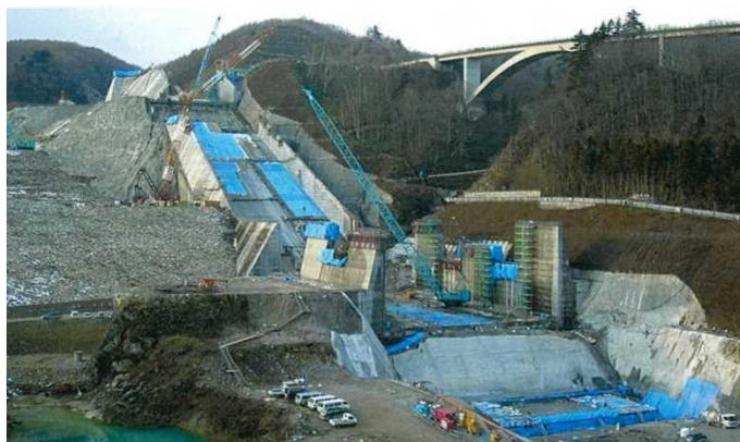
クレーンによるコンクリート打設 施工状況(全体)
