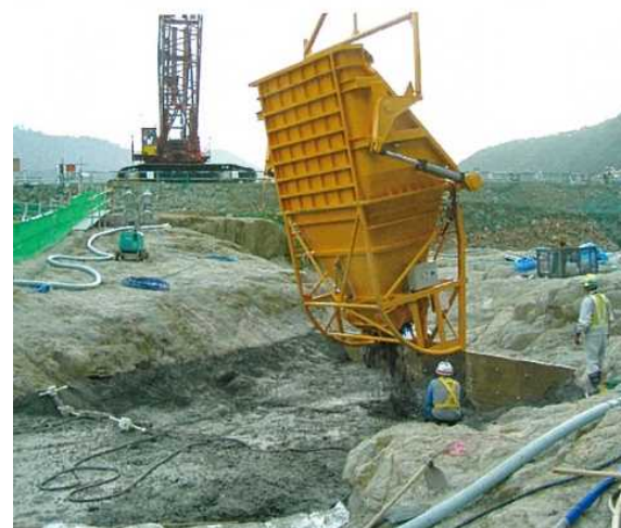
クレーンによるコンクリート打設 施工状況(打設箇所)
