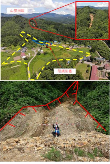
【関東地整TEC-FORCE砂防班の現地調査状況】
