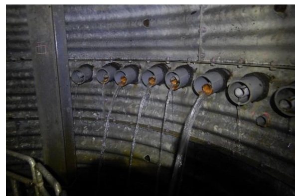
集水井の排水状況
