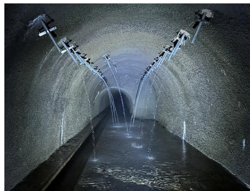
排水トンネルの排水状況
