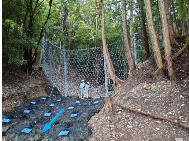
強靱ワイヤーネットを設置し、保全対象に土石流が流下することを防ぐ。 災関砂防の例（滋賀県米原市）
