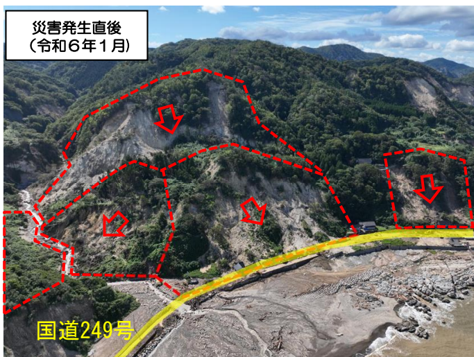
● 令和6年1月能登半島地震における地すべり (石川県珠洲市 奥能登地区)
