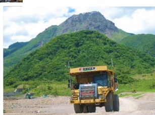
右図：無人化施工重機
