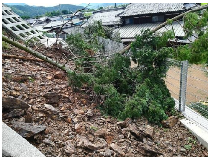
●待受擁壁工により崩壊土砂等を捕捉し家屋を保全
