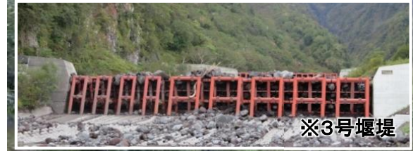
平成28年8月の大雨で土砂を捕捉(2・3号砂防堰堤改良前)
