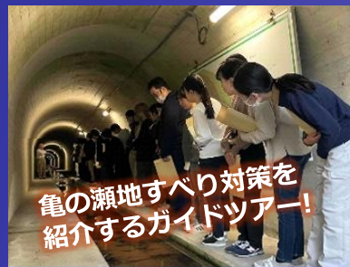
⑫「日本最大級」地すべり対策インフラツーリズム (大阪府柏原市)
