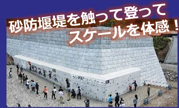
④ボルタリングウォール(秋田県仙北市)
