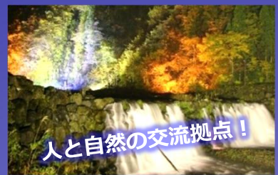
⑩しのぶ砂防堰堤(岐阜県高山市)
