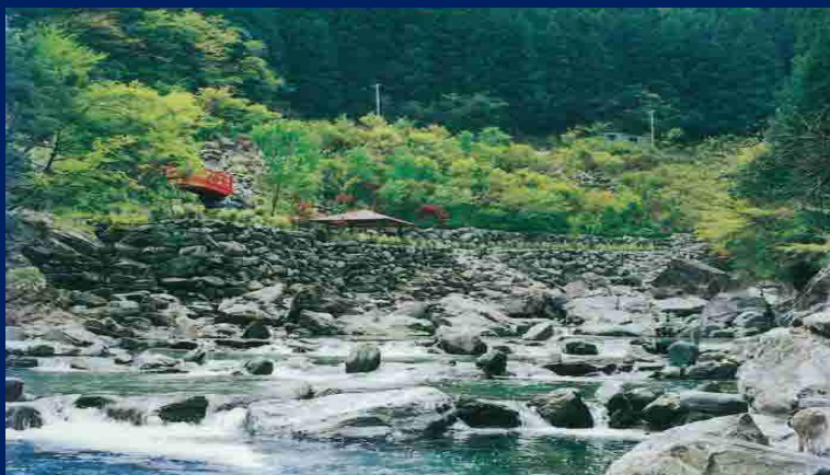
安居川 巨石床固め工群
