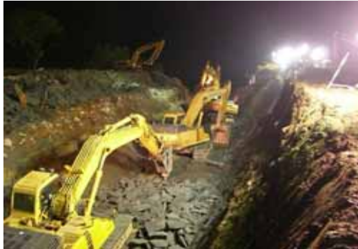
仮排水路掘削イメージ(他事例)
