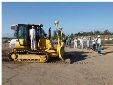
ICT-MC建機(ブルドーザ)の実践
