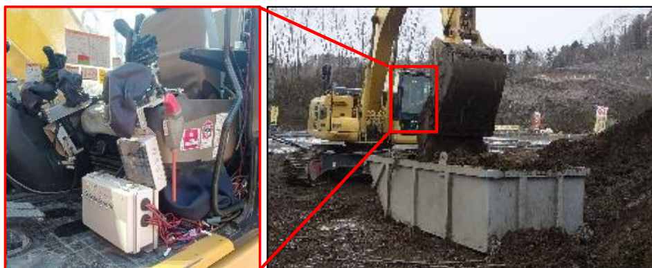
後付型の簡易遠隔操縦装置取り付け状況
