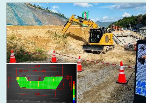
3次元データによるICT施工及び出来形管理
