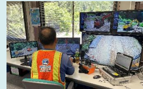
遠隔施工及び自動化機械の操作状況
