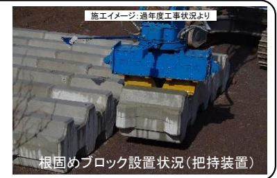
根固めブロック設置状況(把持装置)
