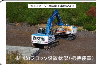
根固めブロック設置状況(把持装置)
