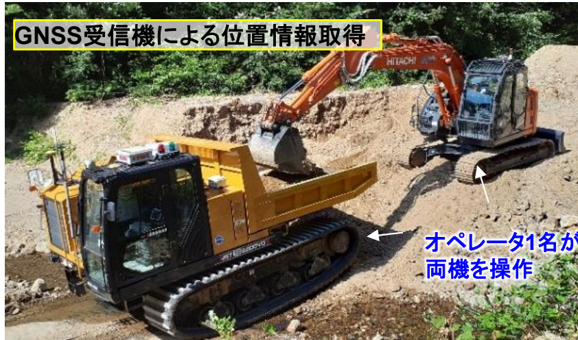
遠隔施工BHと自動化施工クローラダンプによる堆積土砂の掘削
