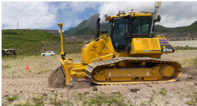
自動化施工ブルドーザの試験施工
