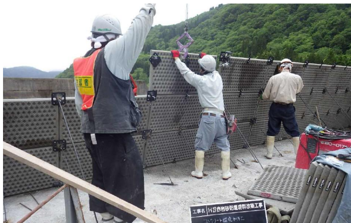
残存型枠設置（クレーン吊込み）の事例写真
