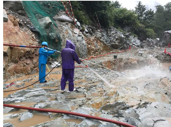
岩盤清掃状況の事例写真
