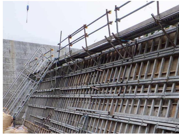
型枠工設置時の安全作業足場の事例写真
