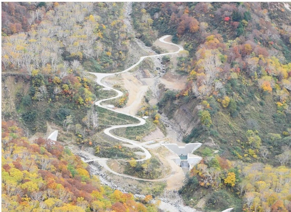
工事用道路設置の事例写真
