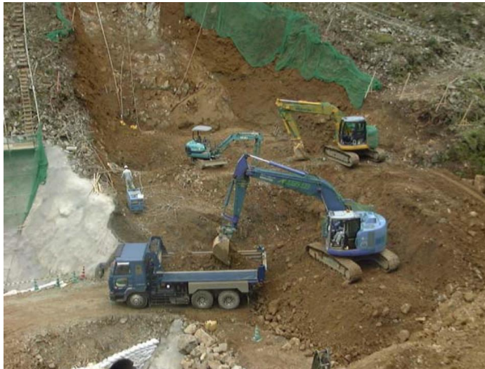
掘削運搬状況の事例写真
