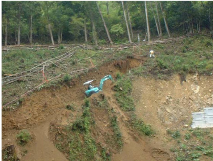
転石破碎状況の事例写真
