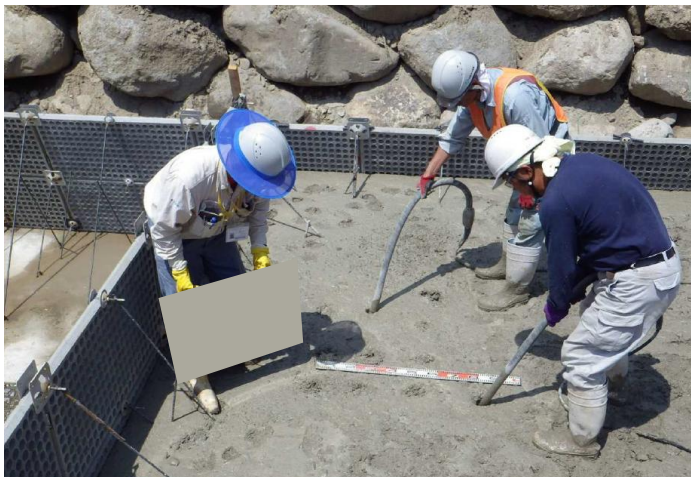
コンクリート締固め状況の事例写真
