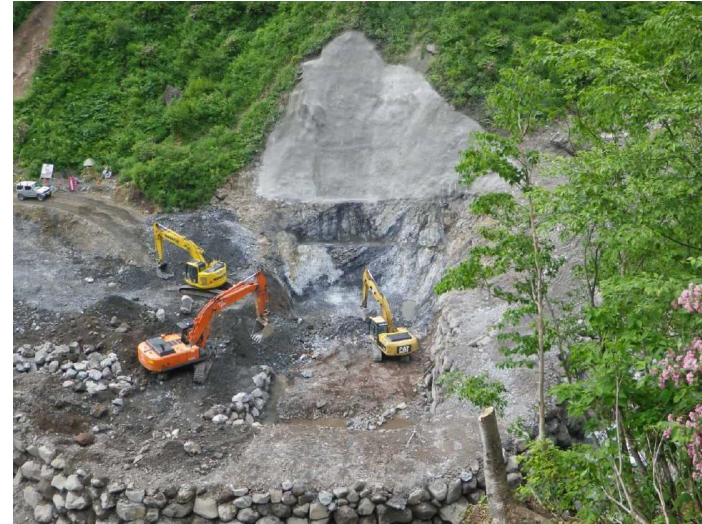
基礎掘削（岩掘削）状況の事例写真
