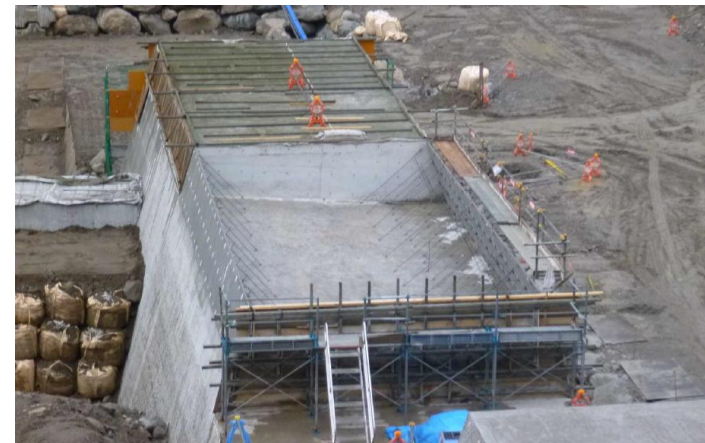
残存型枠設置の事例写真
