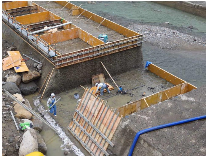
型枠工設置の事例写真
