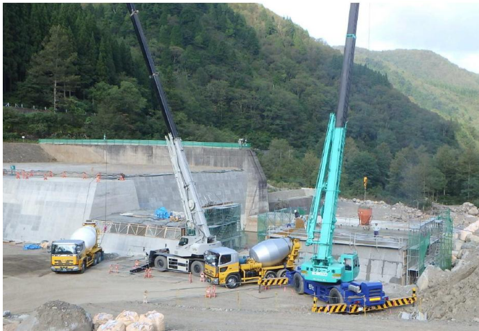
クレーンによるコンクリート打設の事例写真
