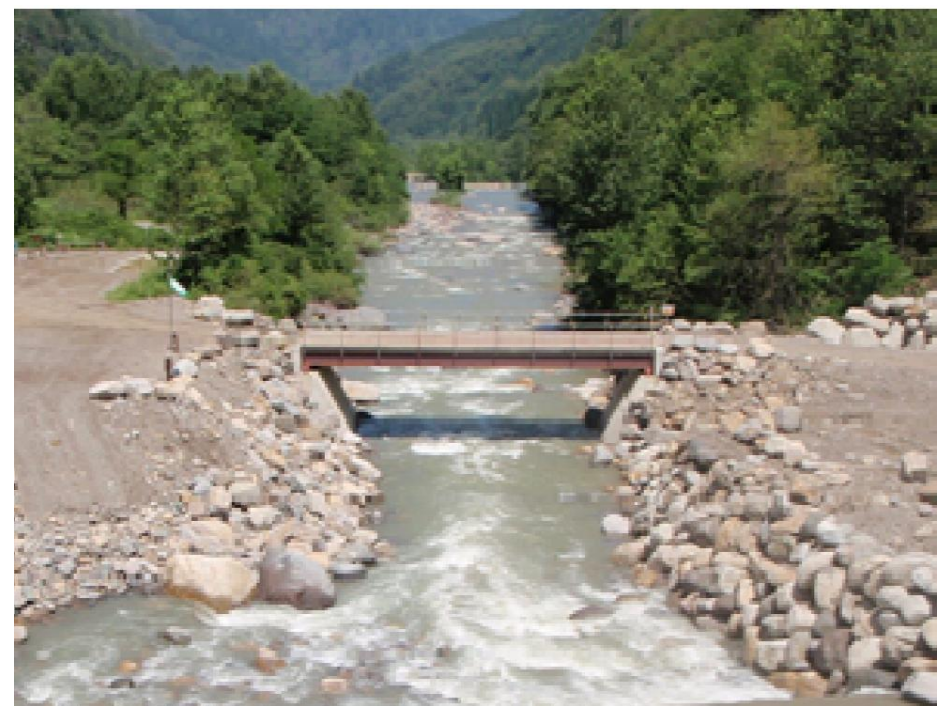
渡河施設(仮橋)の事例写真
