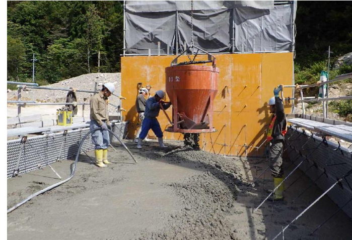
コンクリート打設の事例写真
