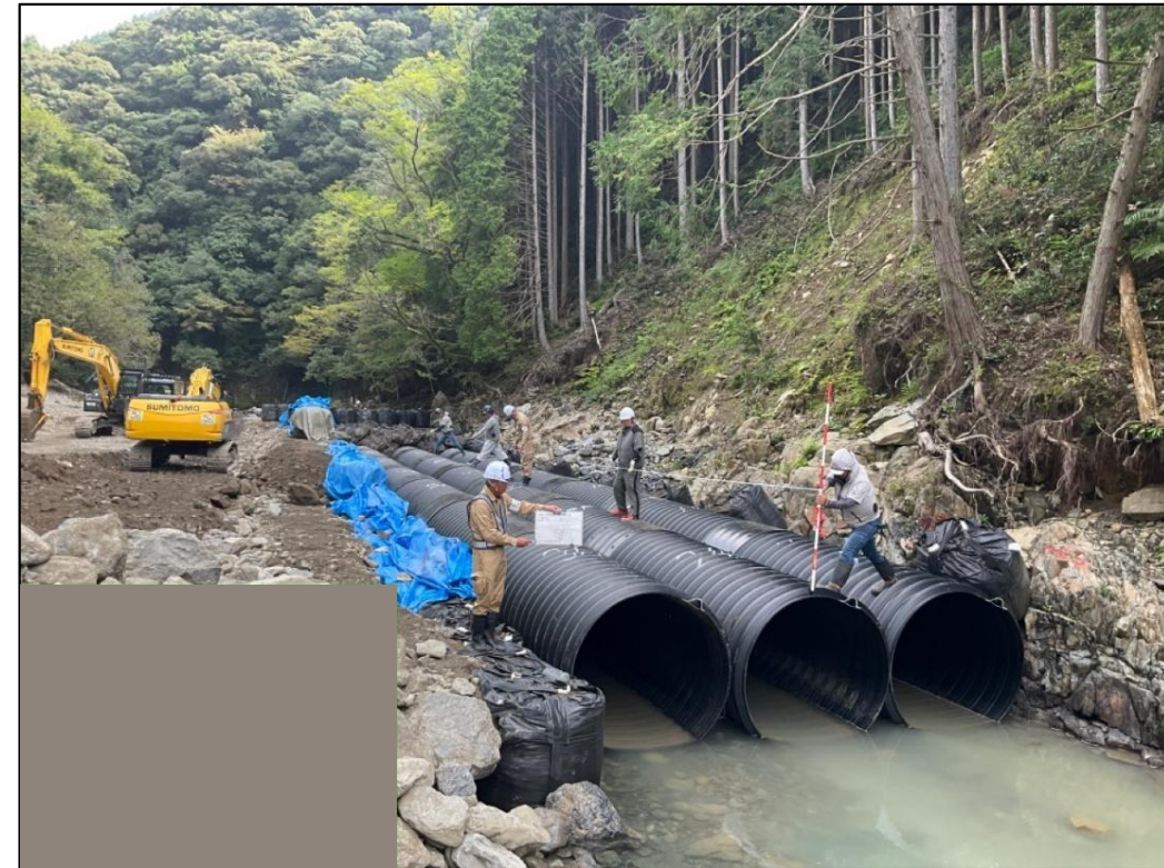
暗渠による転流工設置状況の事例写真
