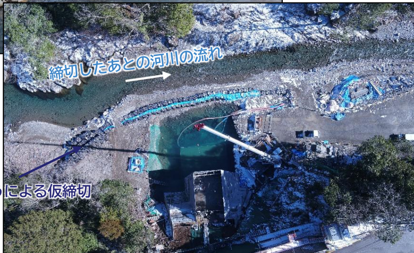
土砂、大型土のうによる仮締切整備状況の事例写真
