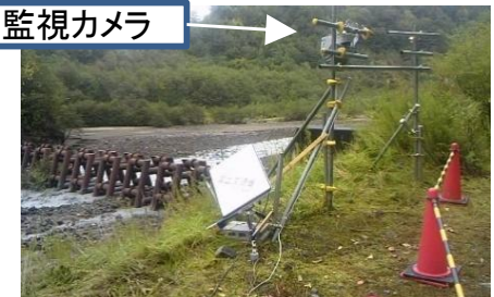
土石流の発生に備えカメラを設置し監視
