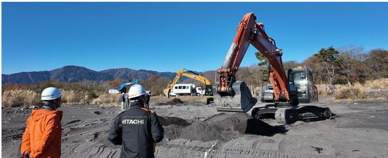
「操作訓練」に参加した管内の建設業者による操作状況
