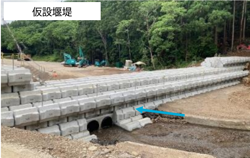
大型土のうの設置（斜面下部の土砂抑え）
