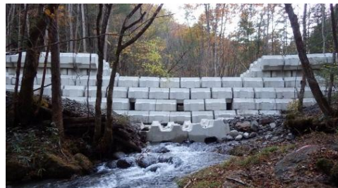
完成したブロック砂防堰堤
