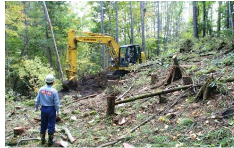
進入路造成作業
