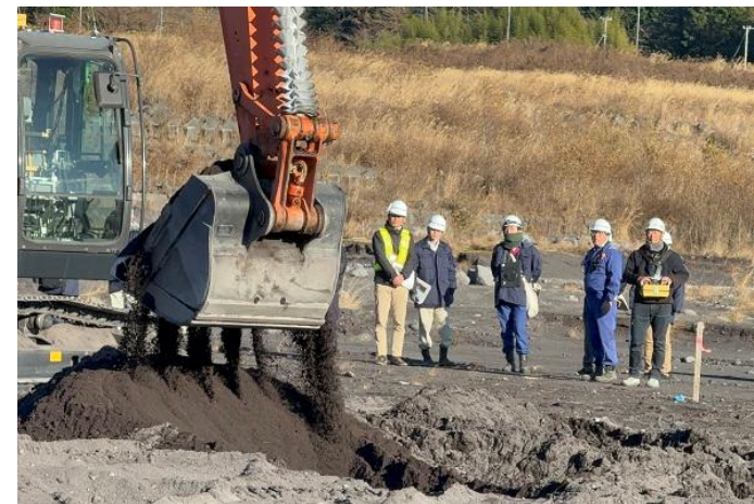
「見学会」での掘削作業の見学
