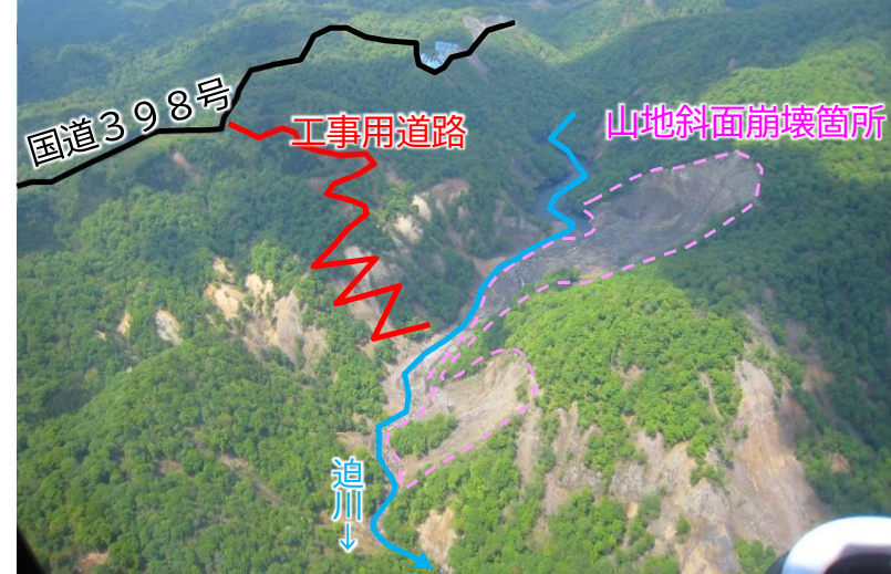
【湯浜地区】山腹崩壊、工事用道路整備状況
