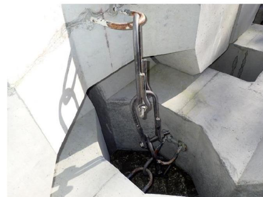
ブロック連結による流出対策
