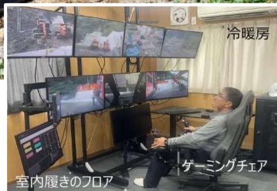
遠隔施工（土砂積込み、運搬の事例）
