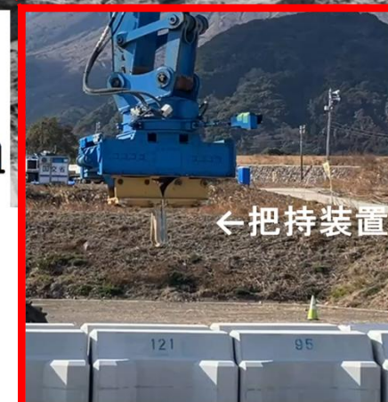
遠隔施工コンクリートブロックの横取・据付の事例
