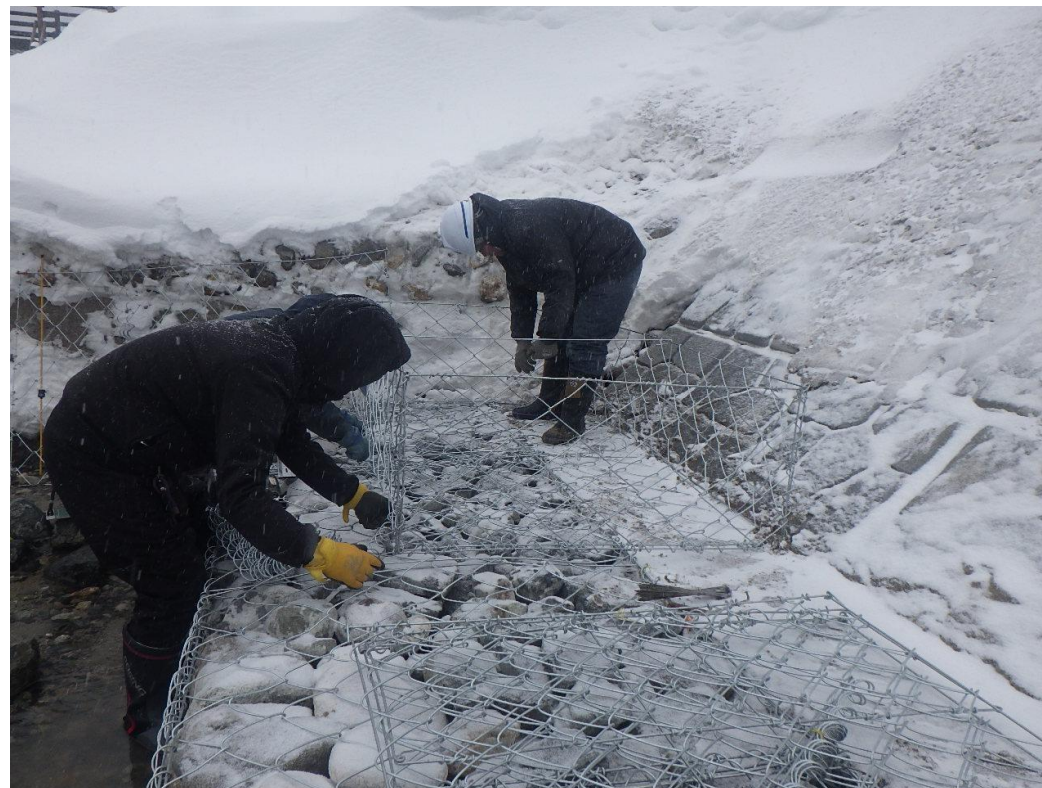
上高地では施工時期が限定
