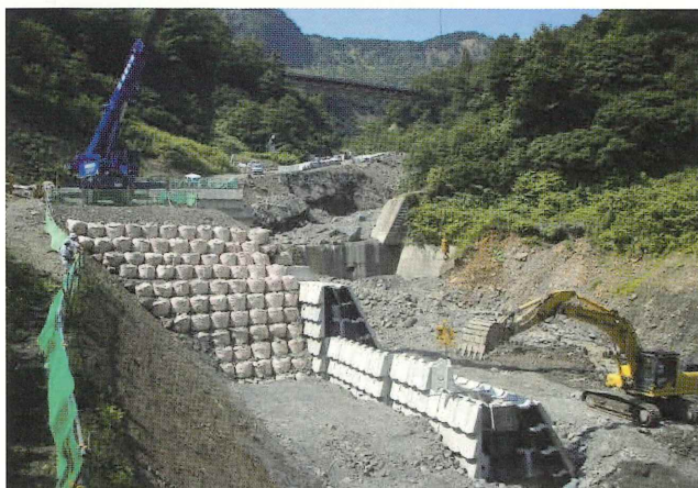
ブロック護岸施工 クレーン(有人)+無人BH+(つるべ)
