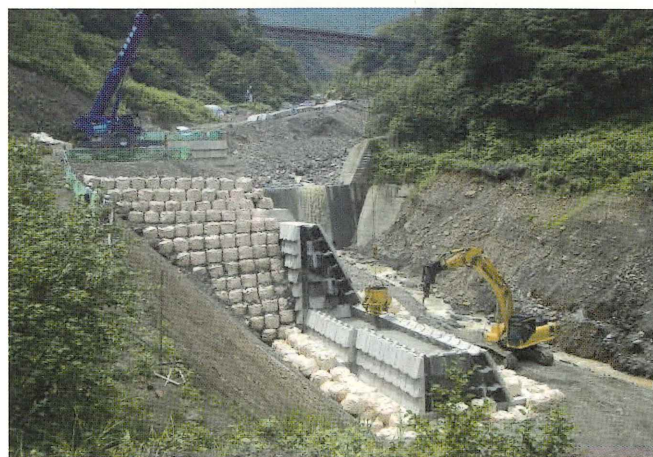
ブロック護岸 コンクリート打設 クレーン(有人)+無人BH
