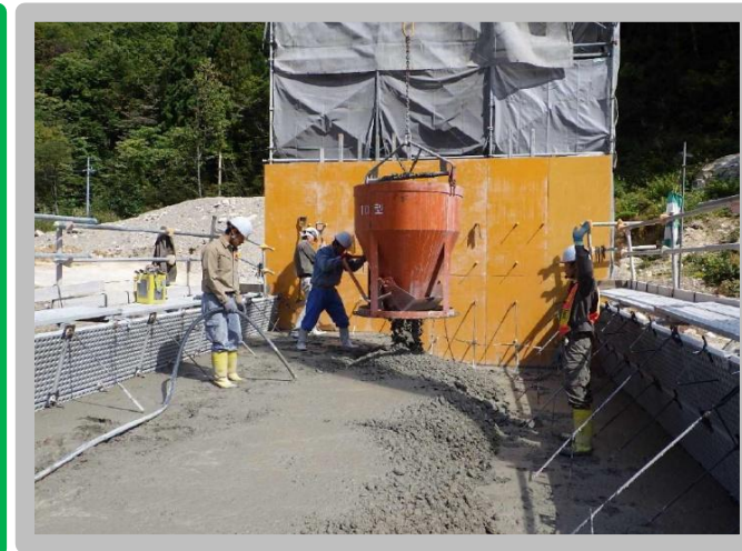
コンクリート打設
