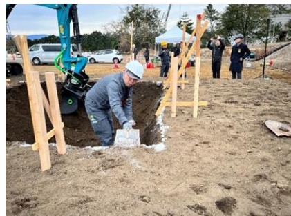
手元作業員が多い現場
