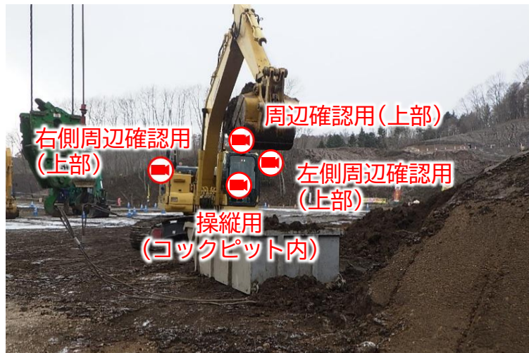
カメラ設置状況 (建設機械)
