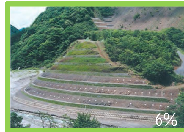
山腹工・斜面对策工
