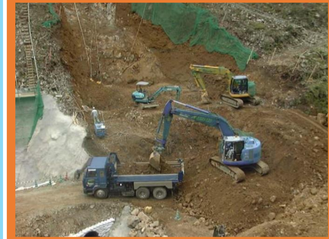
土工（掘削、運搬）
