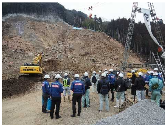
崩壊地現場の調査状況
