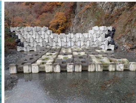
仮設堰堤完成 (平成30年11月29日撮影)
