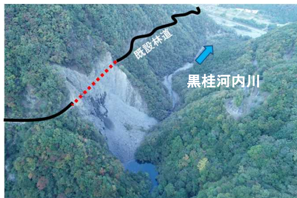
平成30年10月21日発生の崩落状況
