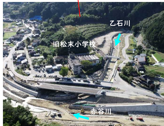
平成29年7月九州北部豪雨を踏まえた今後の対策のあり方【③復旧の基本方針、④他河川への適用】
