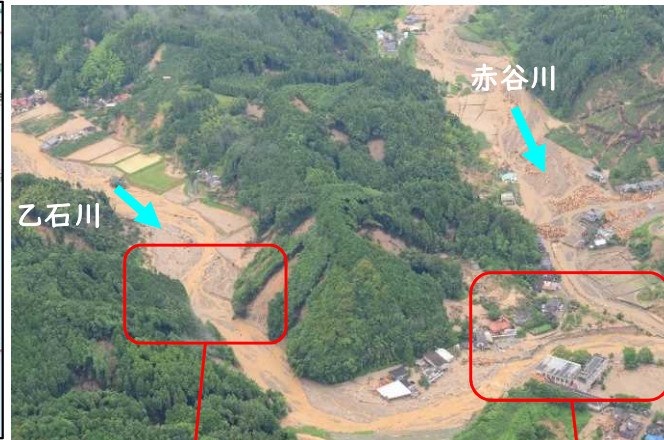
被害状況写真
