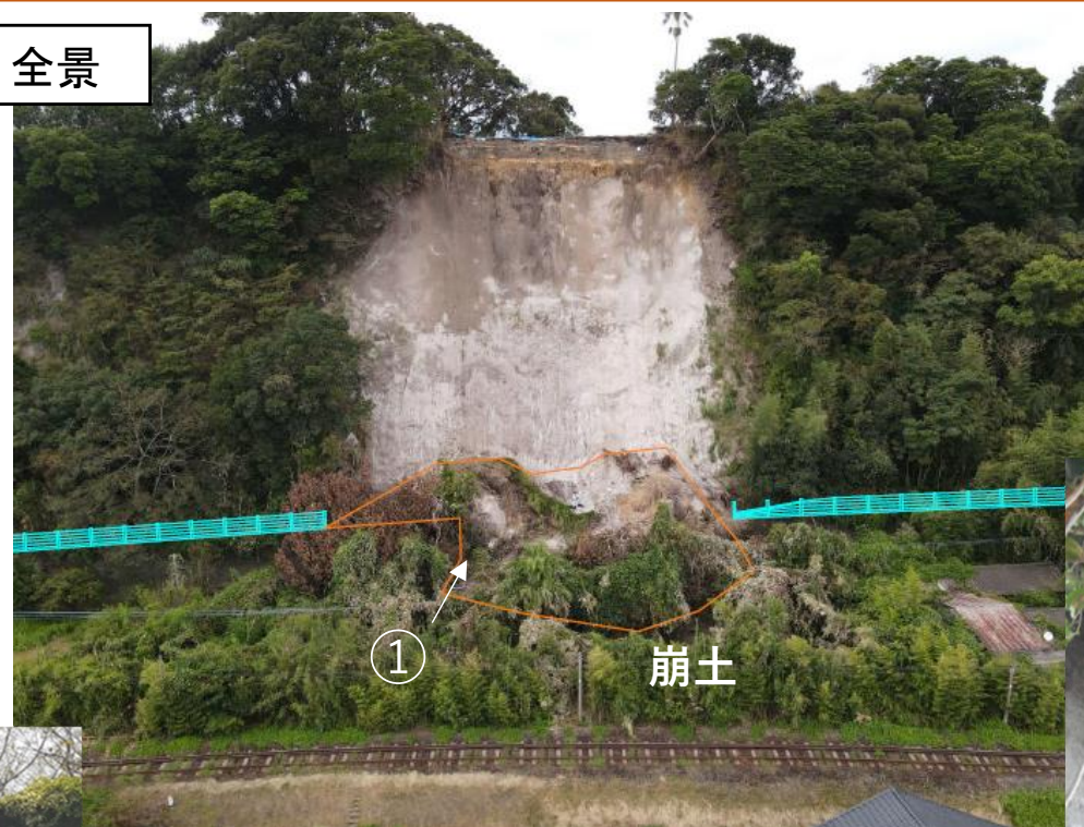
①落石防護柵損傷状況
