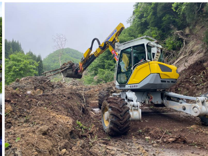
令和7年5月26日～6月6日 石川県珠洲市道726号 道路啓開作業状況 （石川県珠洲市）
