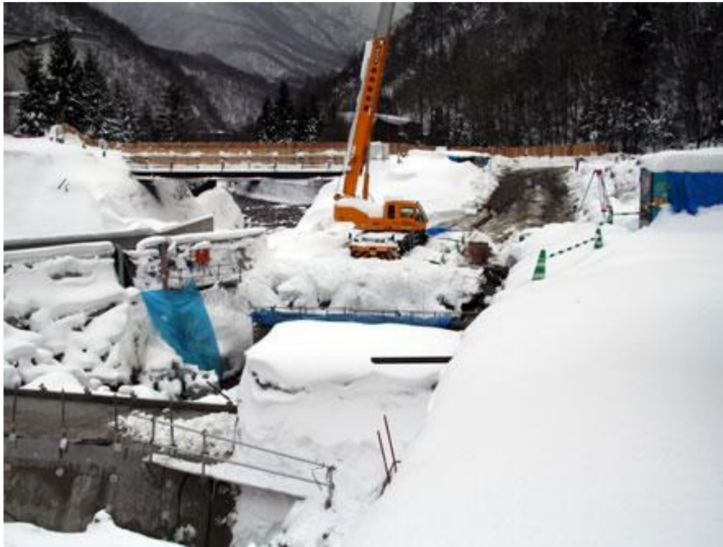
冬期施工の事例（神通川水系砂防事務所）
