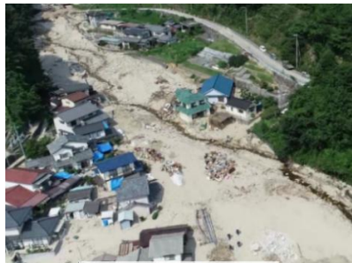
球磨川における浸水被害 (熊本県人吉市)
