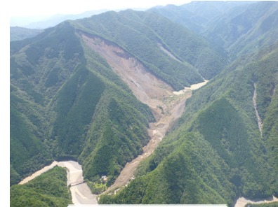
深層崩壊による河道閉塞 (奈良県五條市)
