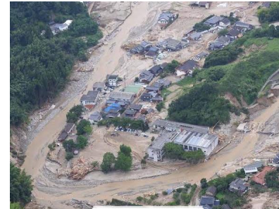
土砂・洪水氾濫 (福岡県朝倉市)
