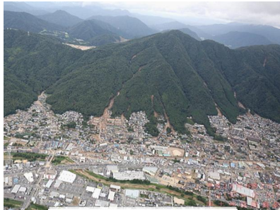
土石流による人家等への被害 (広島県広島市)
