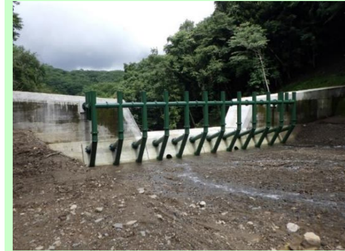
張り出しタイプの流木捕捉工設置事例
