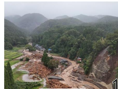
土砂・洪水氾濫 (石川県輪島市)
