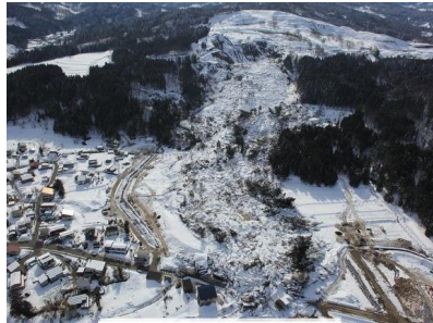
融雪地すべりによる被害 (新潟県上越市)
