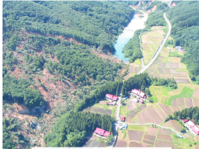
地すべり性崩壊による河道閉塞 (岩手県一関市)
