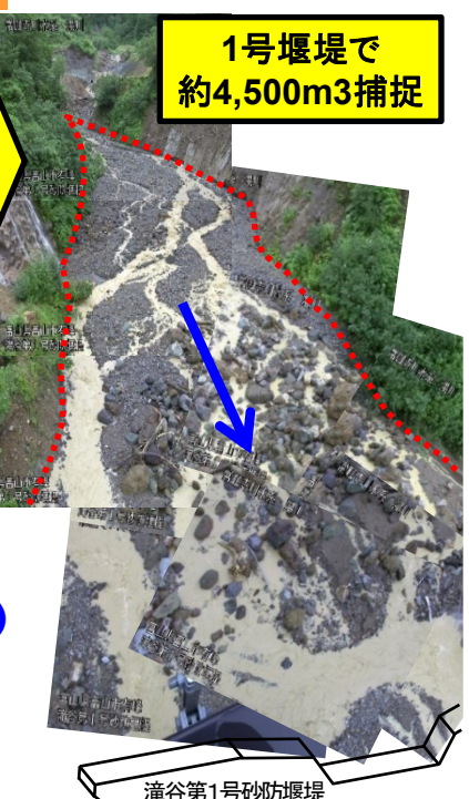
土石流発生直後 (R6.7.12撮影)
