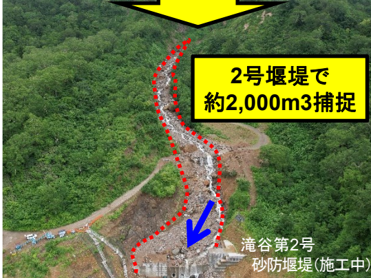
土石流発生直後 (R6.7.12撮影)
