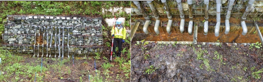
横ボーリング（第8号）の排水状況
