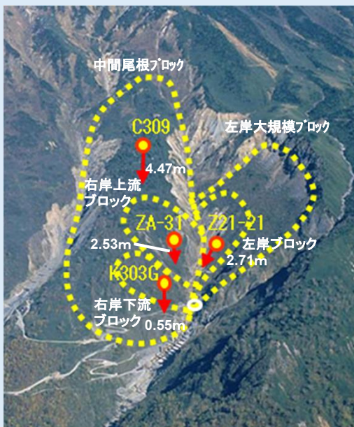
矢印は、S57.10～H23.10(29年間)の地すべりブロック移動方向と移動量 (移動量観測地点K303GとD86Gは平成16年以降)
