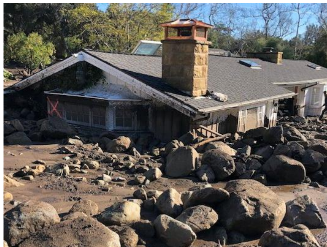
家屋の被災状況(2018)
