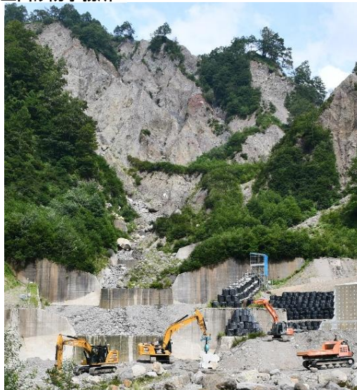
掘削、土砂運搬、ブロック据付
