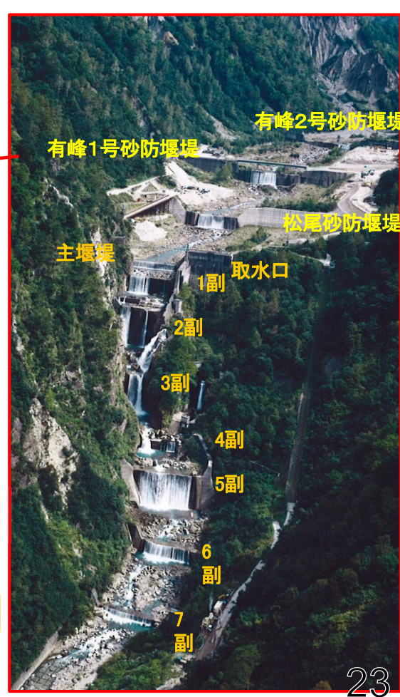
白岩砂防堰堤(S14竣工、H21.6重要文化財指定)
