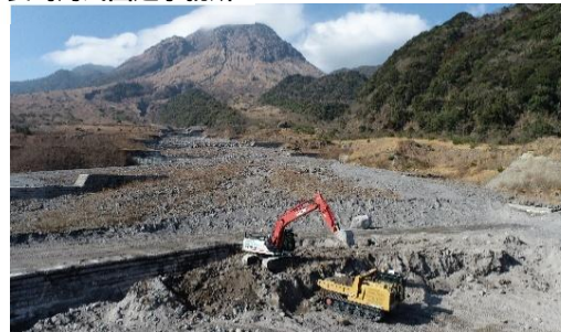
除石、土砂運搬（自動走行）
