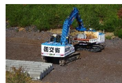
根固めブロック設置状況(把持装置)
