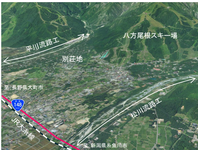
北アルプス山麓扇状地の砂防設備(白馬村)
