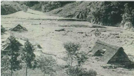
明治40年災害 土砂で埋まった日川村
