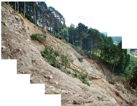
①地すべり頭部の崩壊状況
