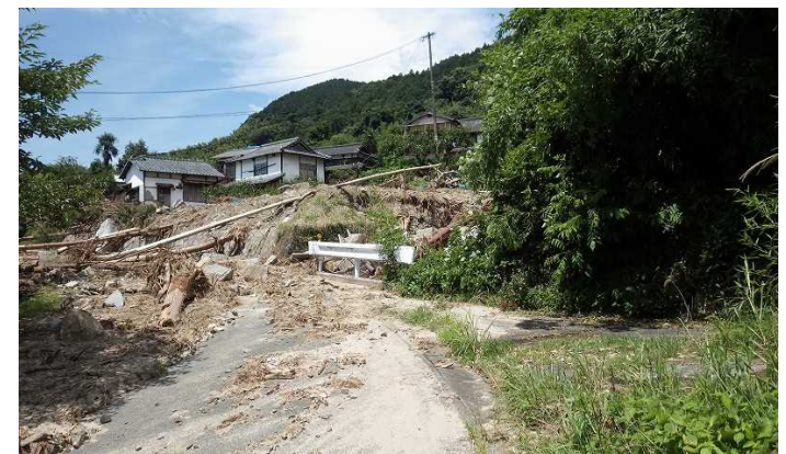
③下流の保全対象(人家、県道)
