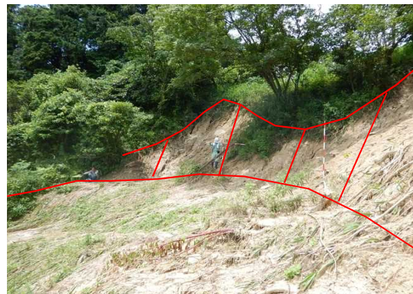
②地すべり頭部の滑落崖
