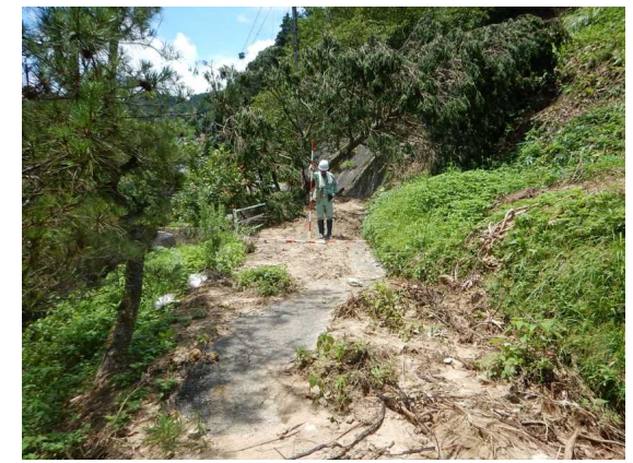
③下流の保全対象(県道)
