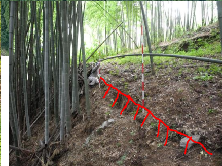
③ブロック側部の段差亀裂
