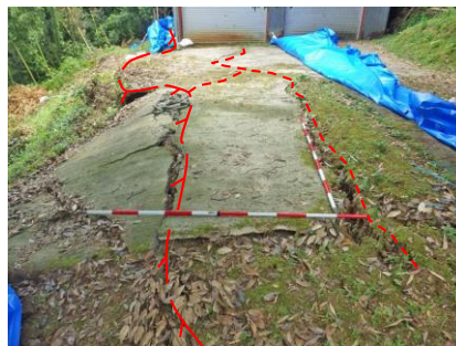
①頭部の滑落崖の状況 (A-2ブロック)
