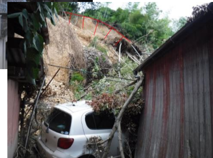
②被害状況
