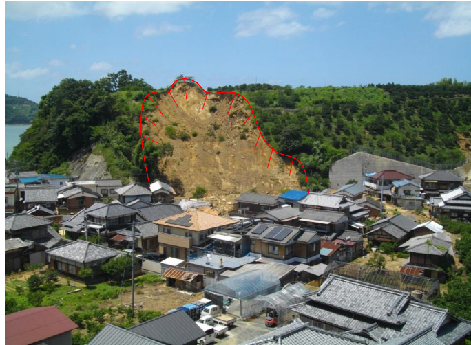
①斜面崩壊状況
