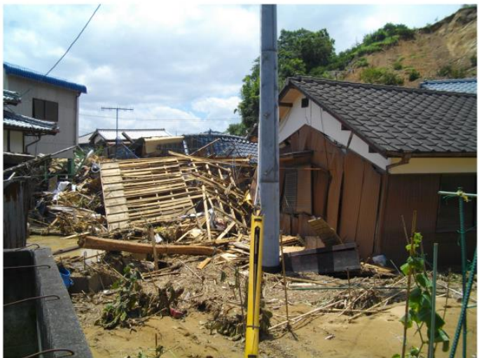
②被害状況
