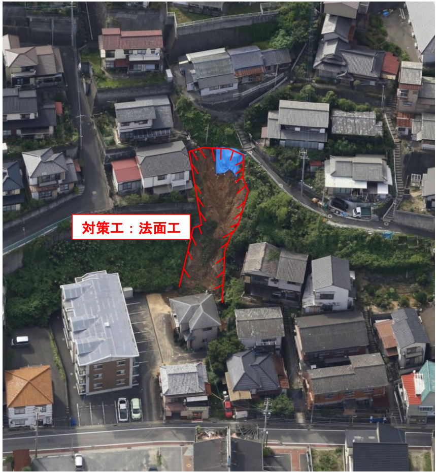
②被害状況
