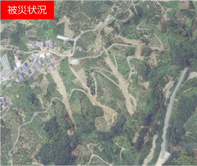
土砂堆積状況
