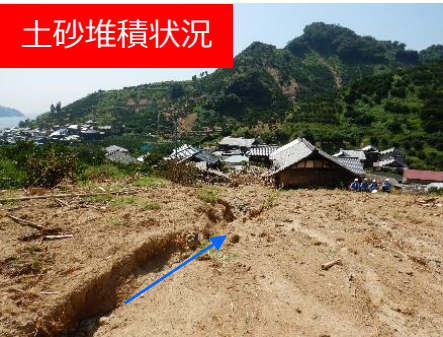
土砂堆積状況
