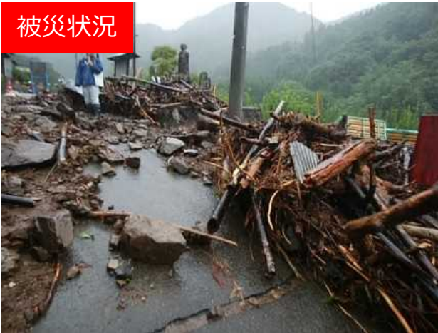
土砂堆積状況
