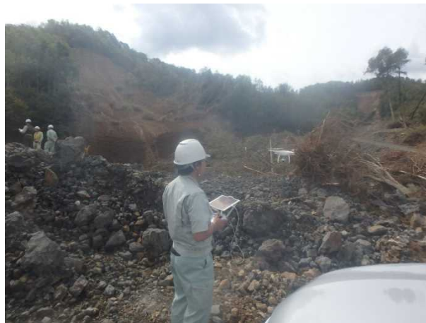
UAVIによる河道閉塞調査(9/25)
