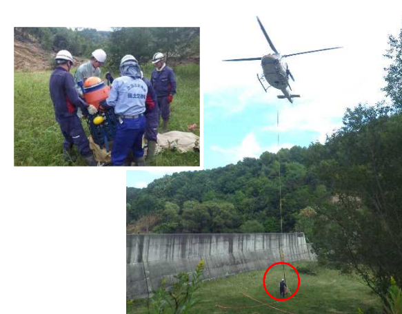
上流側 水位計(水位観測ブイ)設置準備状況
