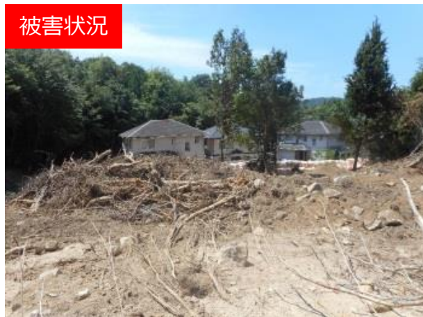
土砂堆積状況
