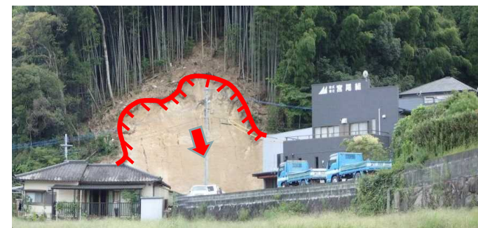
斜面崩壊状況
