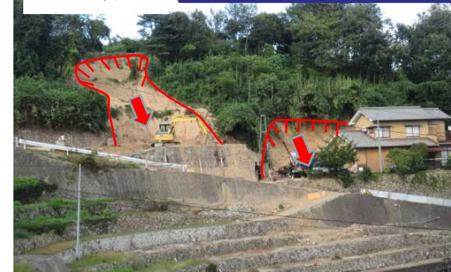
斜面崩壊状況
