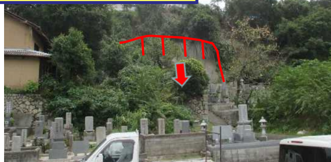
斜面崩壊状況
