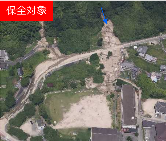
土砂流出状況
