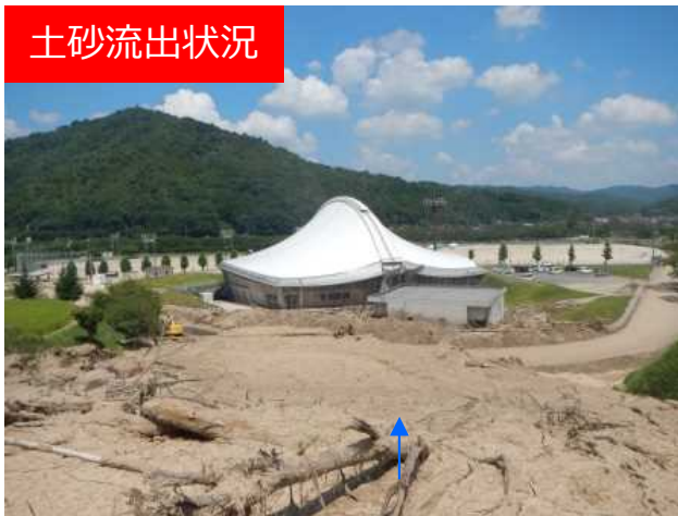
土砂流出状況
