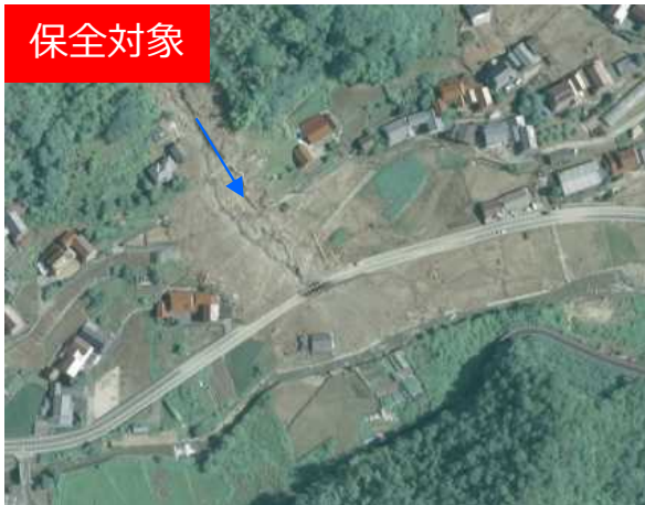
土砂堆積状況
