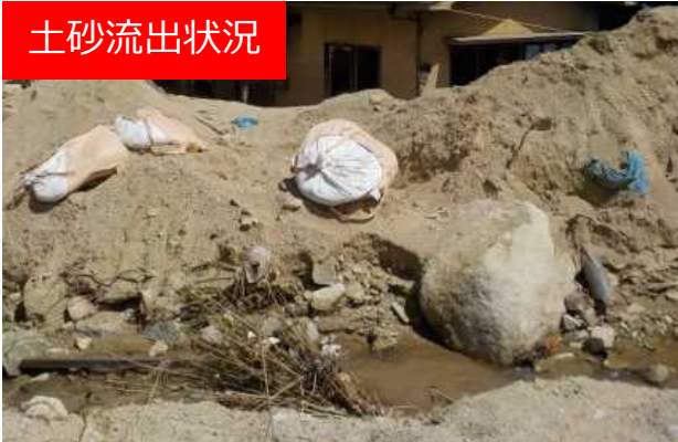
土砂流出状況
