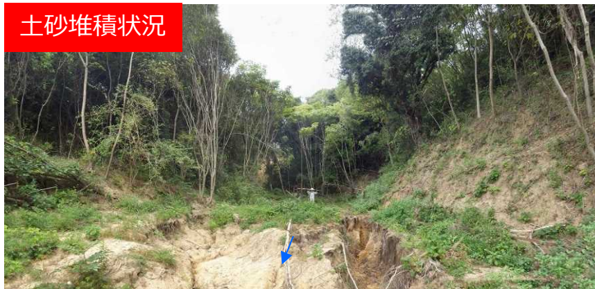
土砂流出状況
